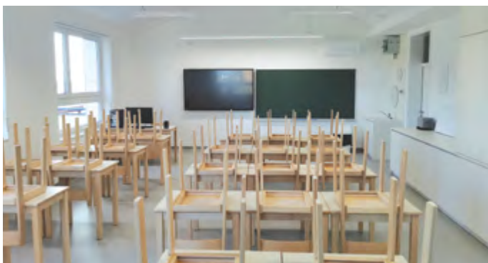
Potek gradnje dveh novih učilnic v OŠ Sečovlje.
