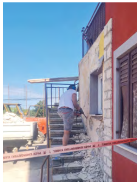
V letu 2021 je KS Sv. Peter začela najbolj nujna vzdrževalna dela na objektu.
