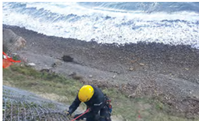
Sanacija klifa pod župniščem.
